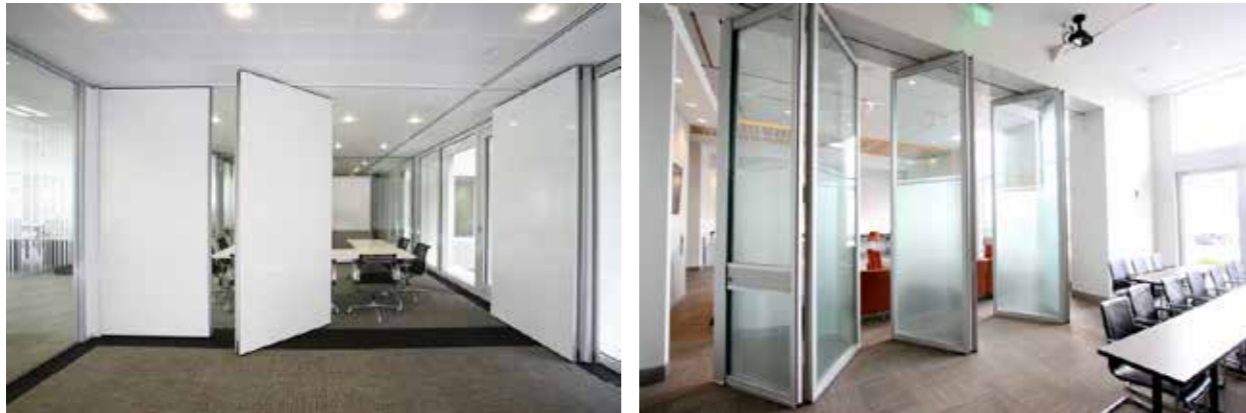
Obr. 3.10a a 3.10b: Posuvné alebo skladacie deliace steny umožnia dosiahnuť priestorovú flexibilitu v spoločenských a terapeutických priestoroch (zdroj: firma Deavita).
