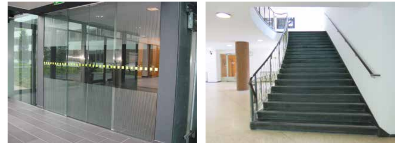
Obr. 3.13 vľavo: Zasklené plochy a dvere sú kvôli vznikajúcim reflexiám často slabo vnímateľné a preto musia byť označené vo grafickými symbolmi.
