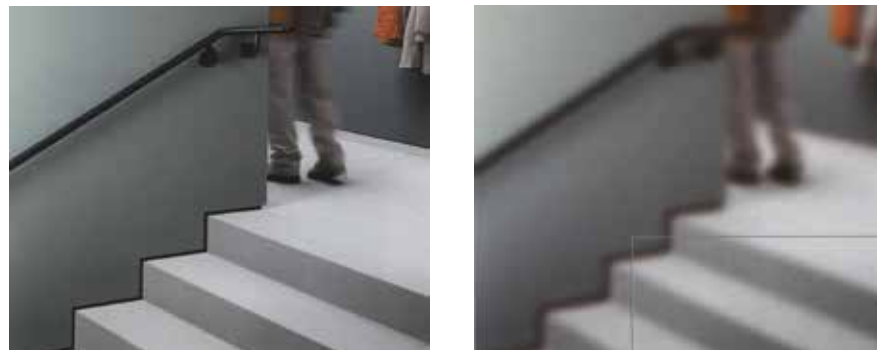
Obr. 8.1 a 8.2: Kontrast medzi stenou a schodiskovým ramenom zlepšuje vnímateľnosť priestoru a zlepšuje bezpečnosť pri používaní schodiska (obr. vpravo znázorňuje vnímanie kontrastov slabozrakou osobou) (Firma Hewi)
