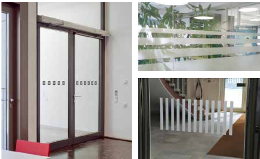
Obr. 8.5 – 8.7: Sklenené dvere sú často slabo vnímateľné, a preto musia byť vo výške očí označené výrazným pásom, symbolmi a pod.
