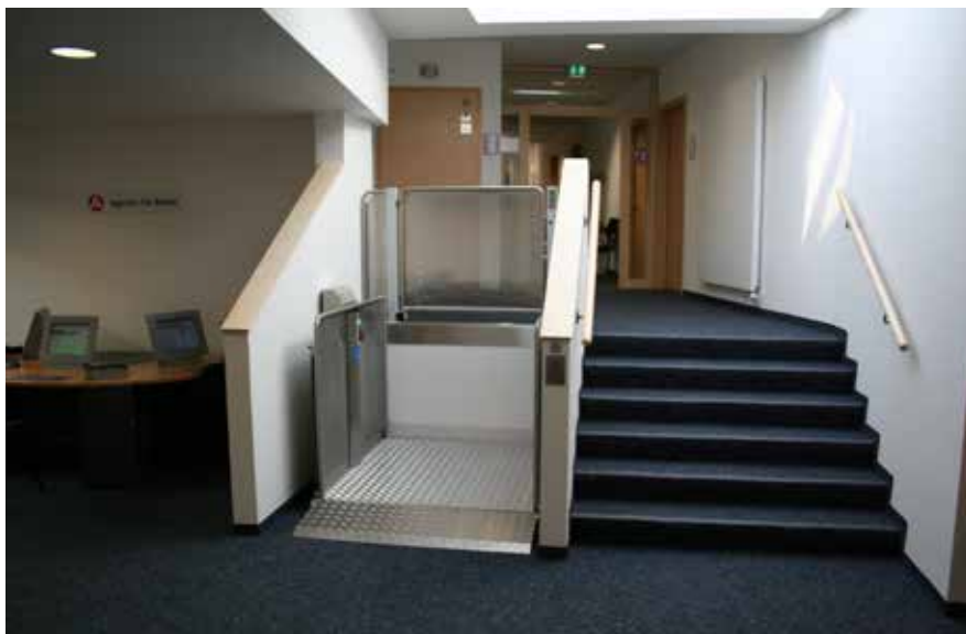
Obr. 8.33: Zvislé zdvíhacie plošiny možno realizovať v interiéri aj exteriéri (Firma: Lift Reith)
