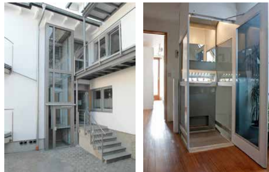
Obr. 8.34: Zvislú zdvíhaciu plošinu možno používať rovnako komfortne ako výťah (Firmy: Velcon, Ares)
